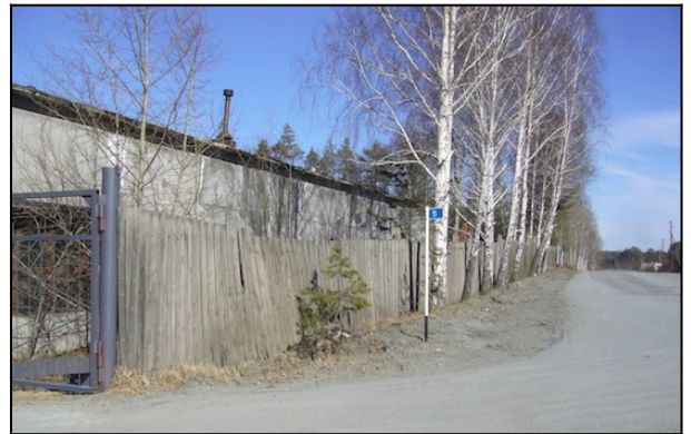
Сооружение – ограждение складов ОТС, инв.200059
