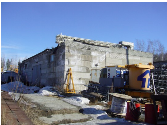
Здание теплого склада ОГМ, инв.200237
